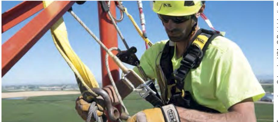
**1. Организация страховки при подъеме с помощью страховочного стропы с двумя усами и интегрированным амортизатором рывка**
